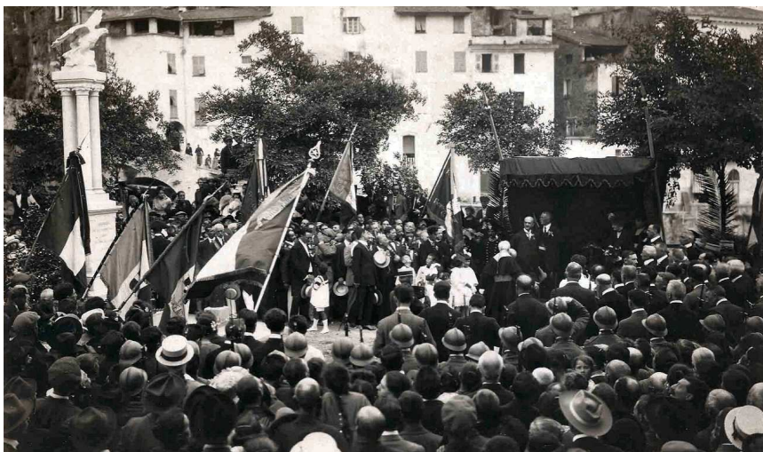
Fig. 2 - 1921. Inaugurazione Monumento ai Caduti a Dolceacqua, con il sindaco Gio Antonio Raimondo (foto archivio F. Vigliani).
