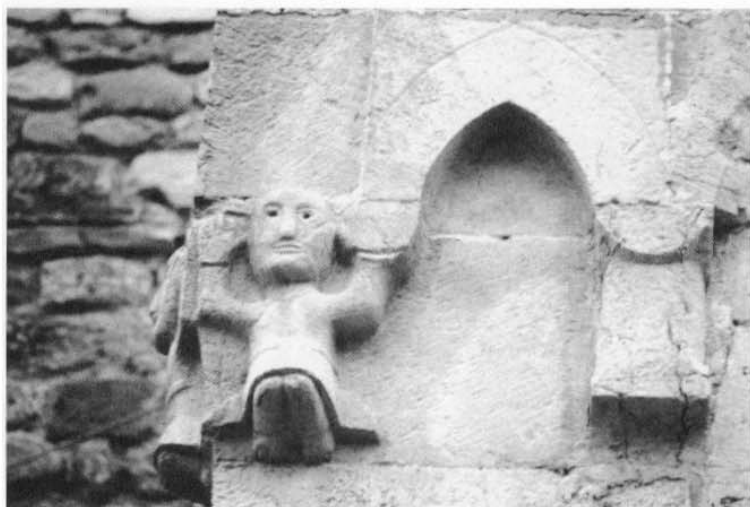
3 - Esterno dell'avancorpo, parte sinistra, «telamone», archetto e semicolonnina
