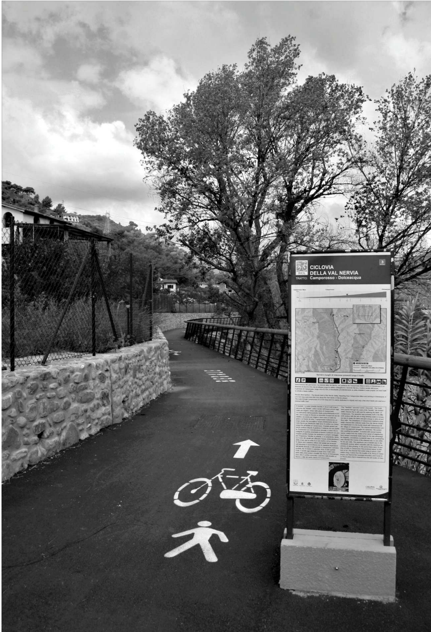
Foto 1 - Camporosso, località Cian de Ca' . Ciclovia della Val Nervia, passerella su Bedale e tabellone informativo (foto Federica Romeo).
