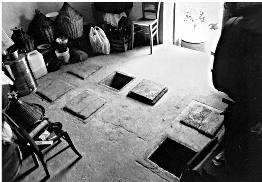
Fig. 5 -Trugoli per la conservazione dell'olio in una casa di via Roma. La capacità totale è di 16.450 litri.
